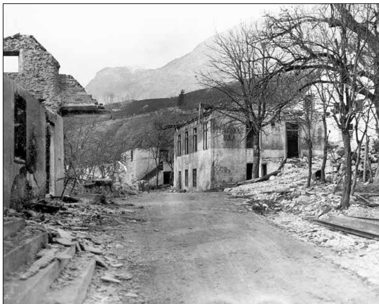
Porušene hiše v Kalu
