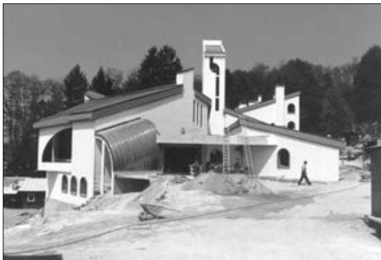
Gradnja župnijske cerkve sv. Cirila in Metoda v Škofljici po načrtih arhitekta Franceta Kvaternika, 1986
