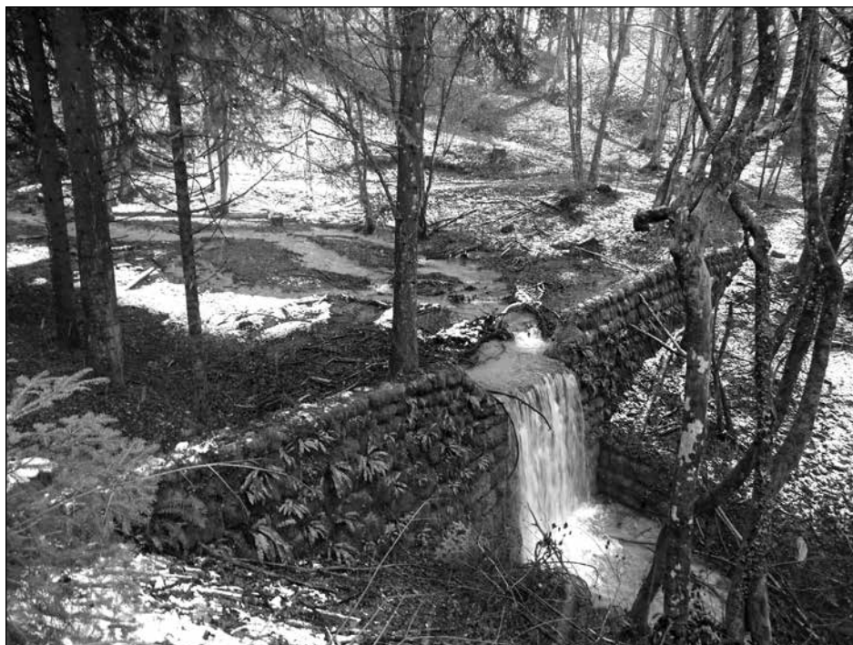
Zaplavna pregrada na Šumečem potoku gorvodno od vasi Jugorje.
