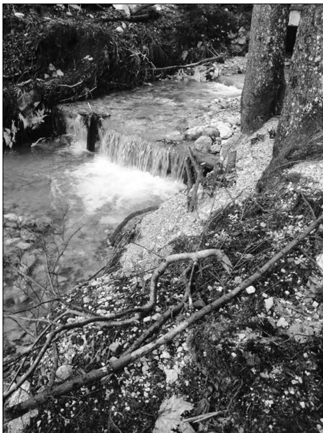
Manjša lesena zaplavna pregrada in s kamni tlakovano dno manjšega potočka v parku Tivoli v Ljubljani, ki je aktivnejši ob deževju.
