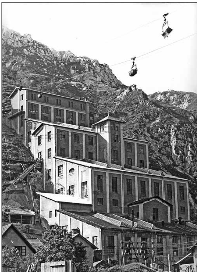
Stavba separacije v Žerjavu
