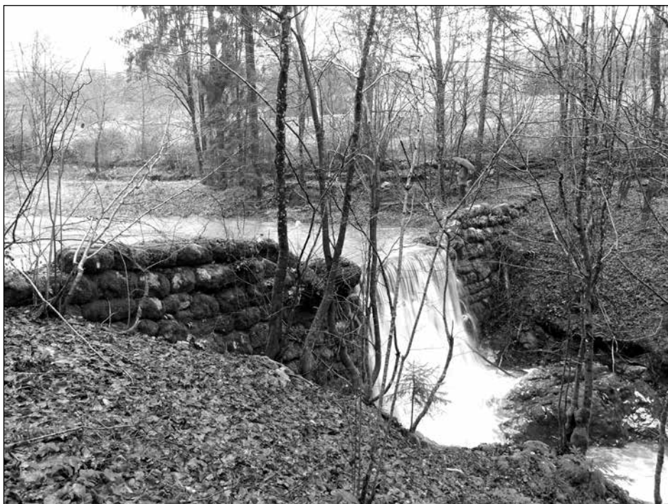
Zaplavna pregrada na potoku Klamfer pod vasjo Dolž ob večjem vodostaju, ko se voda preliva skozi preliv pregrade.
