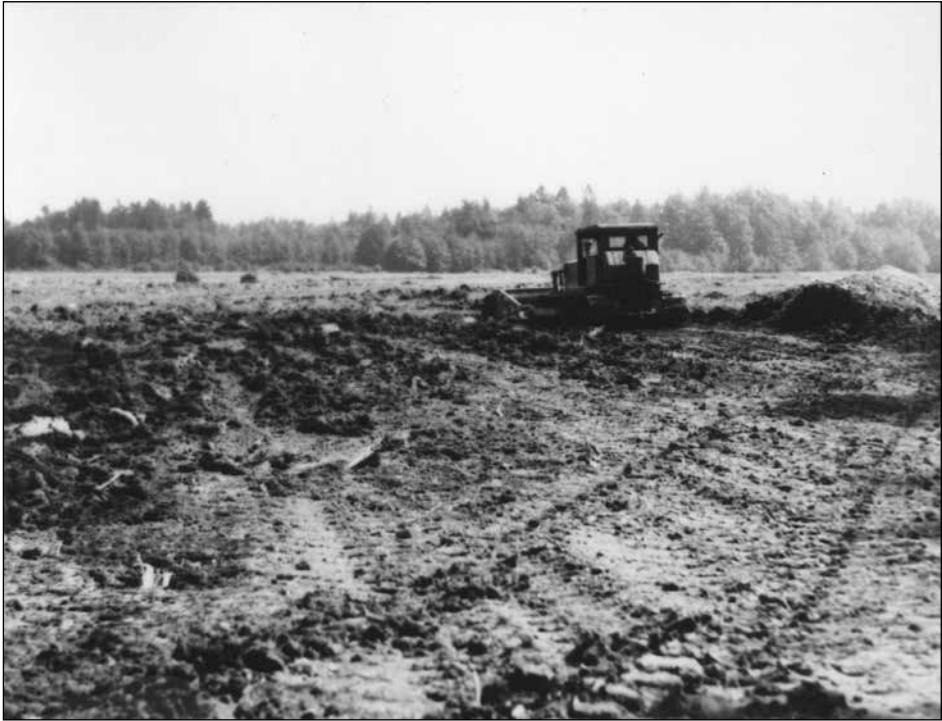
Obrat Bokalce. Melioracijska dela na novem kompleksu ob Tržaški železnici.
