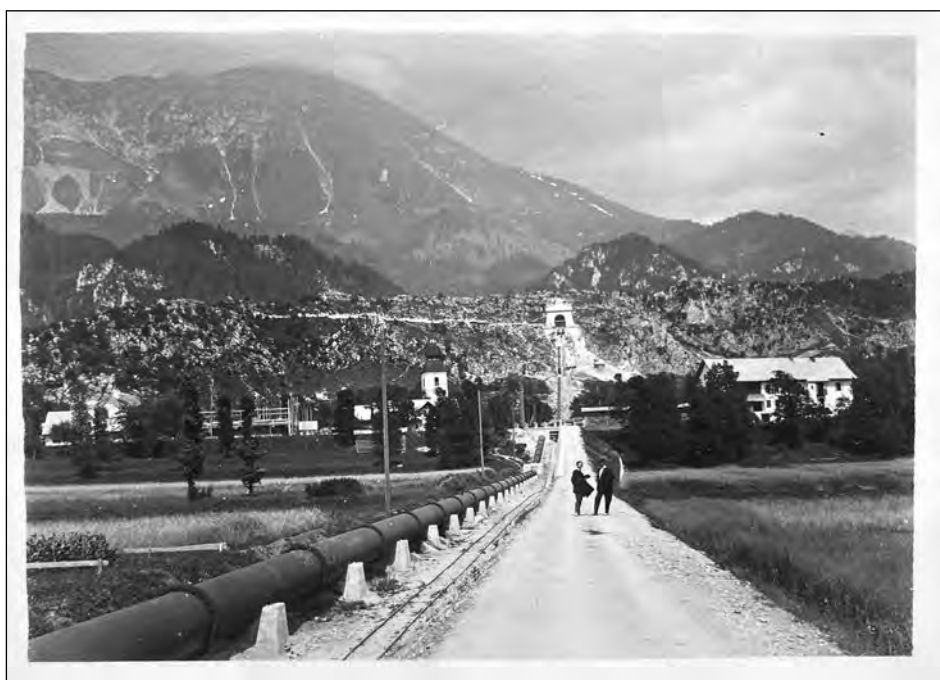
Železna cev in vodostan hidroelektrarne Završnica
