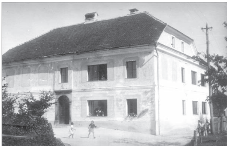
Osnovna šola na Igu z delno zazidanimi okni, ki so bila poškodovana v času druge svetovne vojne.
