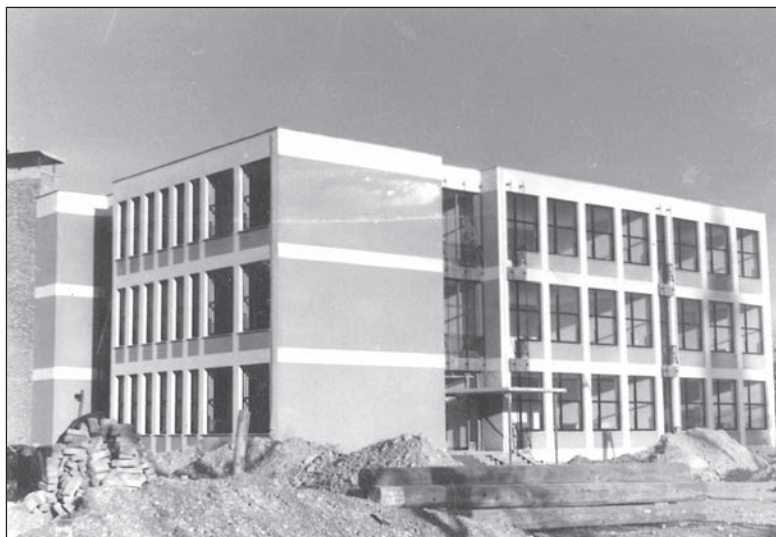
Šolsko poslopje tik pred izgradnjo
